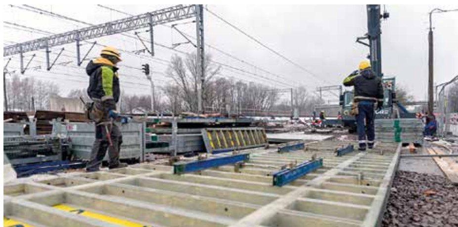
Na placu budowy
