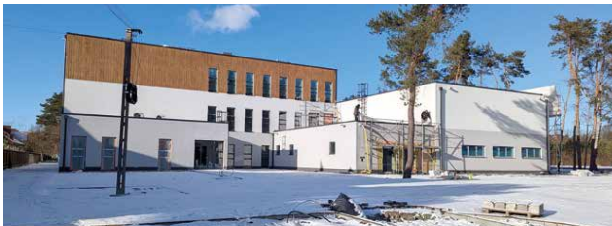
Szkoła w trakcie budowy
