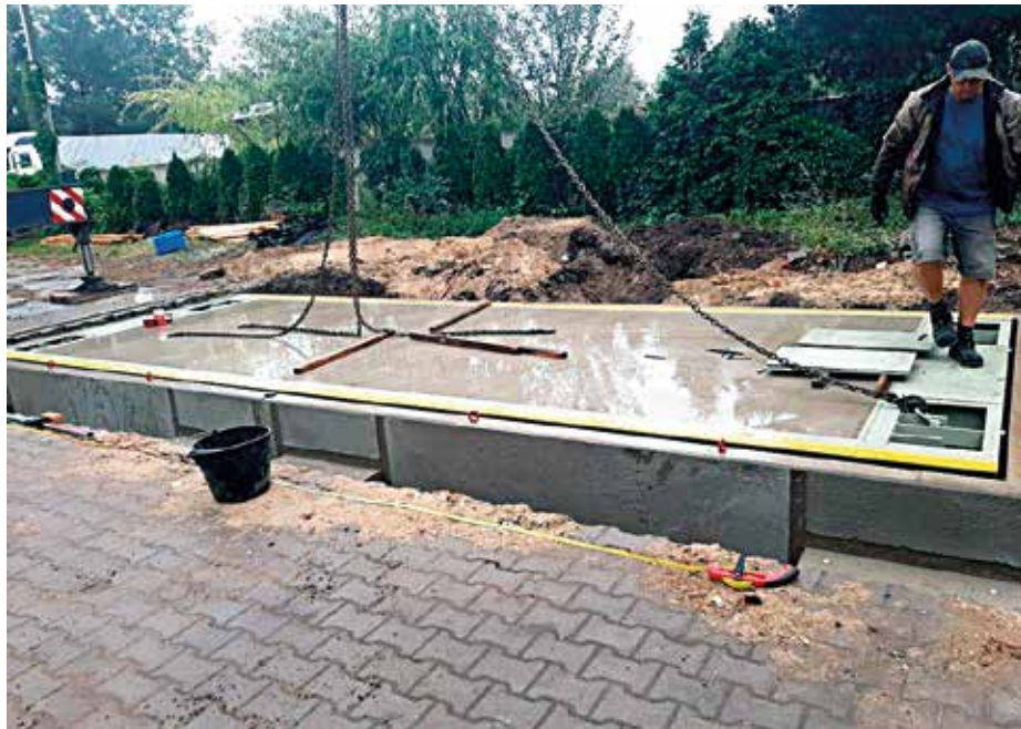
Budowa systemu wag do ważenia odpadów w PSZOK w Kobyłce
