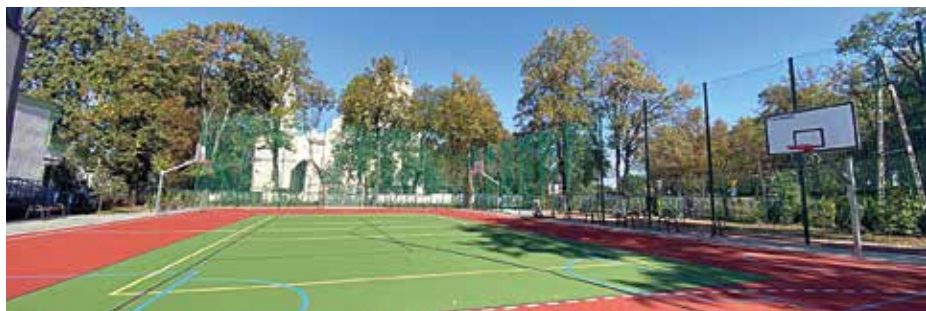
Boisko po przebudowie
