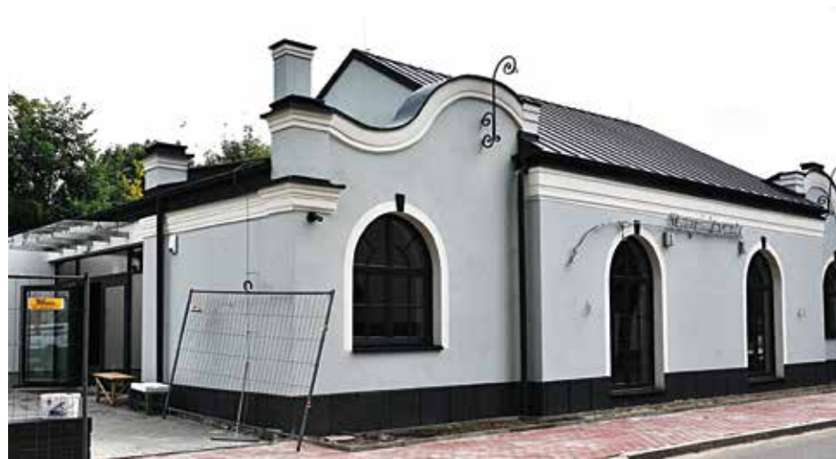
Stara Elektrownia po remoncie w pełnej krasie
