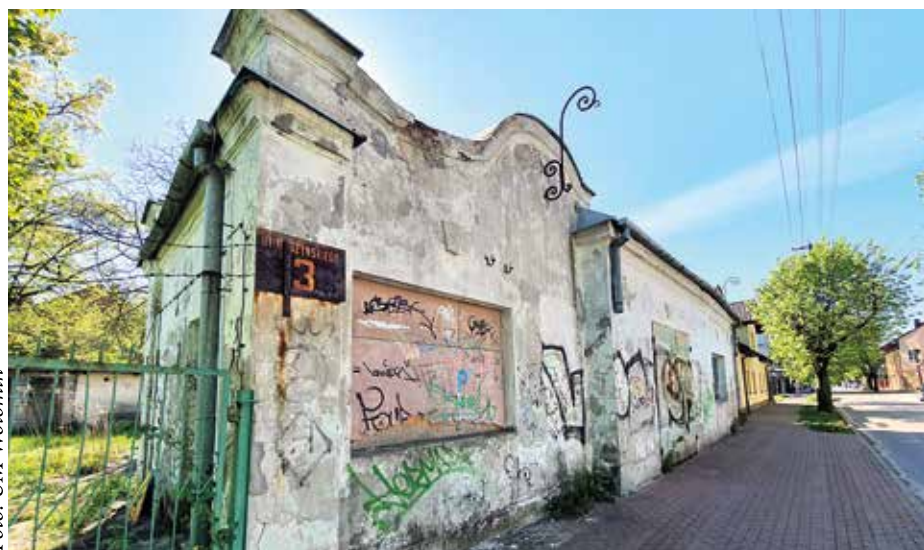
Budynek przed remontem
