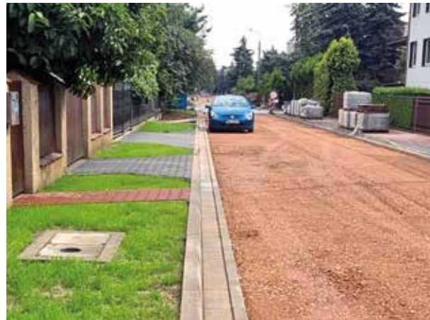
Ulica Lisa Kuli z nową nawierzchnią
