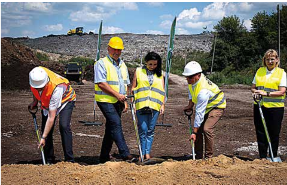
Symbolicznie wbito pierwsze łopaty na terenie budowy
