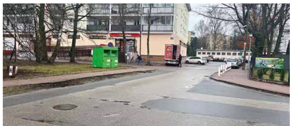
Droga wewnętrzna na Osiedlu Poligon będzie modernizowana
