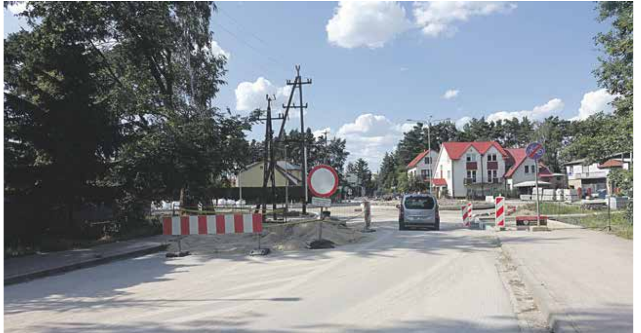
Po wylaniu asfaltu objazd zostanie skierowany ulicami Langiewicza i Sosnową
