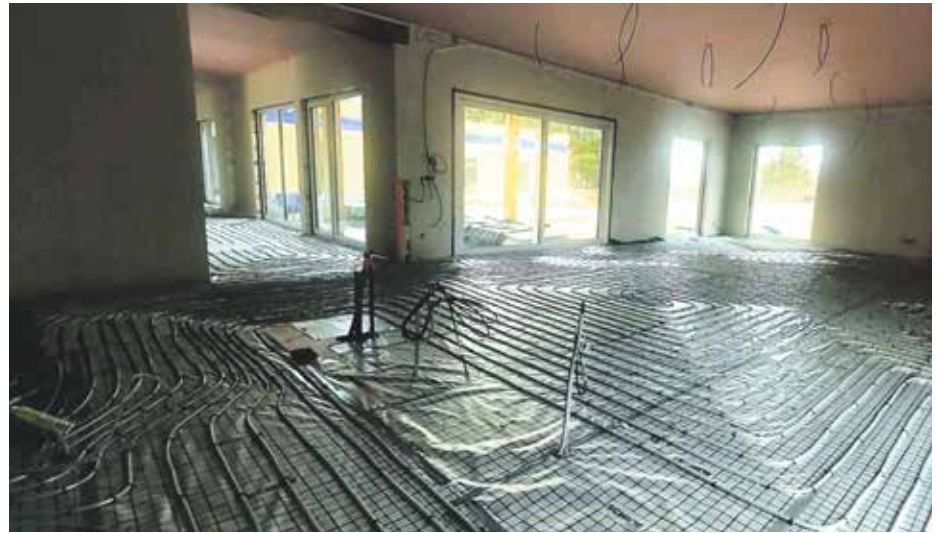
Postępy przy budowie centrum opiekuńczo-mieszkalnego
