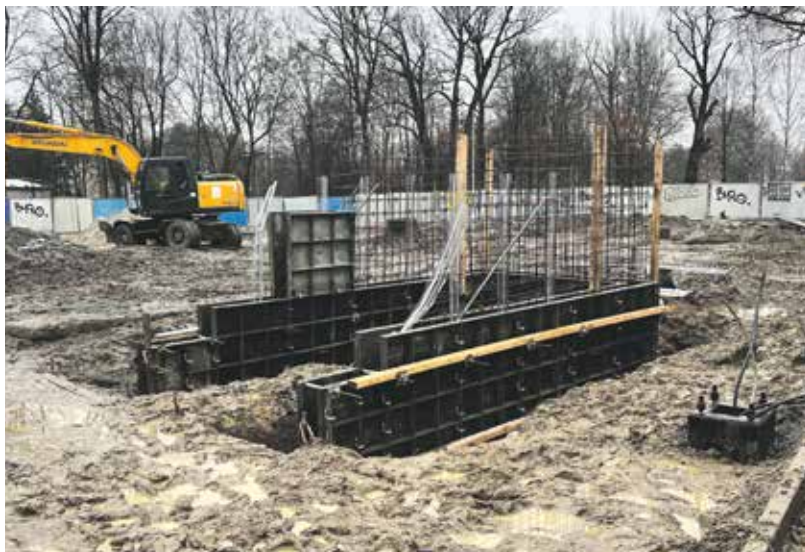
Budowa w toku
