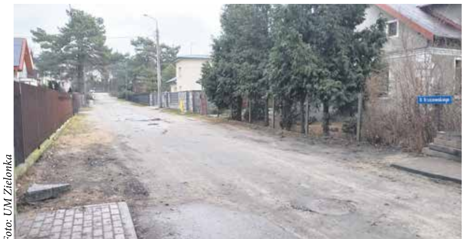
Foto: UM Zielonka Ulica Kraszewskiego przed remontem
