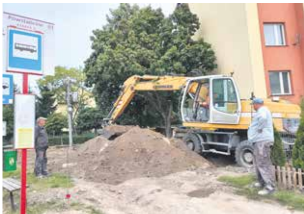
Prace rozpoczęły się w ubiegłym tygodniu
