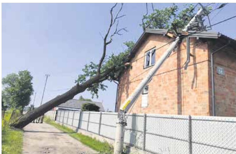
Powalone drzewo i słup wysokiego napięcia
