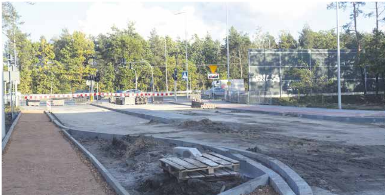
Budowa skrzyżowania uniemożliwia wyjazd z ul. Szwoleżerów na DW 631. Dużo samochodów zawraca, co może sugerować, że postawiona tablica z informacją o zamknięciu wyjazdu jest mało widoczna i niewystarczająca
