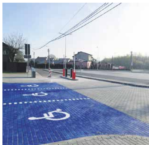
Parking „Parkuj i Jedź” przy stacji PKP Kobyłka Ossów z czytelnie oznakowanymi miejscami dla niepełnosprawnych
