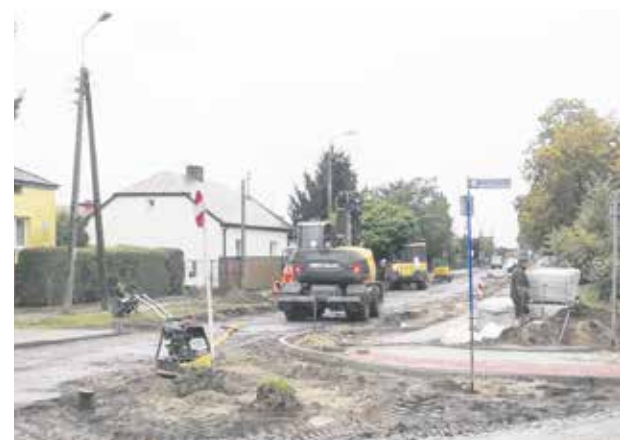
Prace trwają na wielu ulicach miasta
