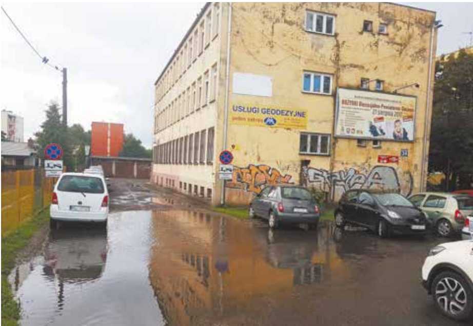
Jeszcze rok temu na parkingu przed budynkiem Spółki stały wielkie kałuże
