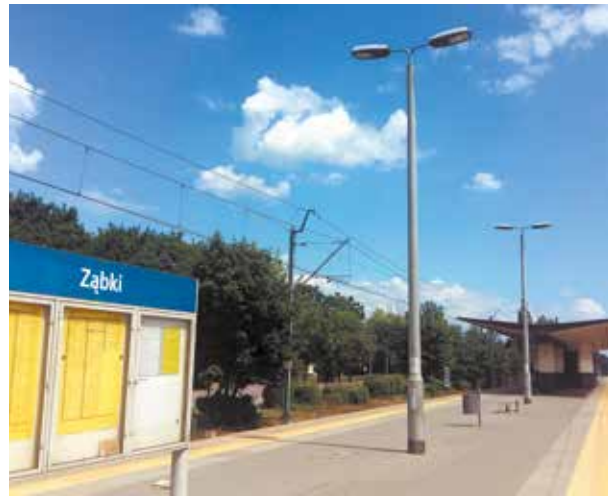
Infrastruktura na peronie w Ząbkach nie jest obecnie zbyt bogata
