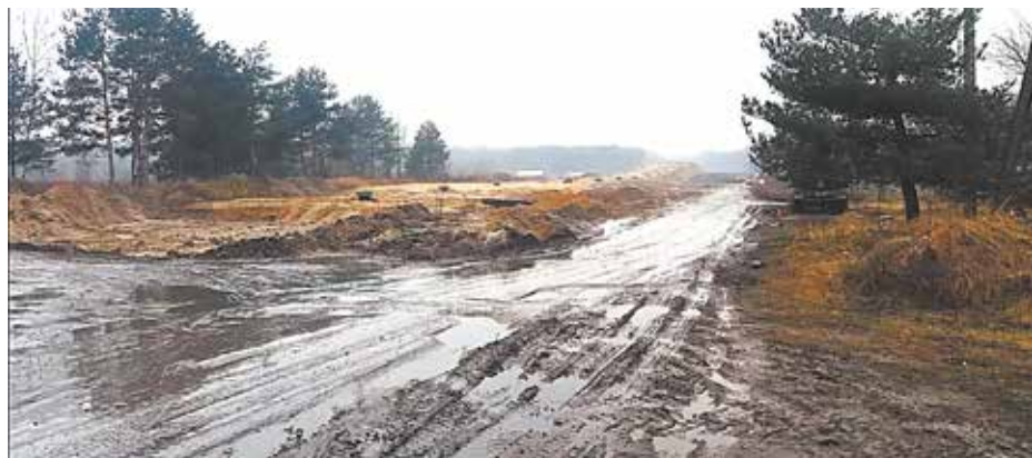
Ulica Dworkowa - widok na nasyp pod wiadukt nad Trasą S8
