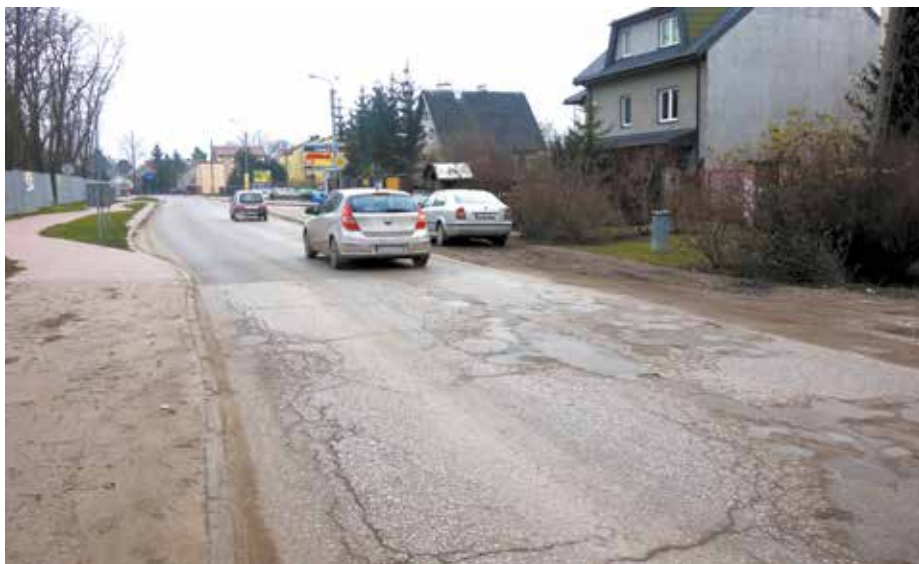
Część ulicy Drewnickiej w Ząbkach została zmodernizowana w 2016 roku. Teraz czas na przebudowę pozostałego odcinka
