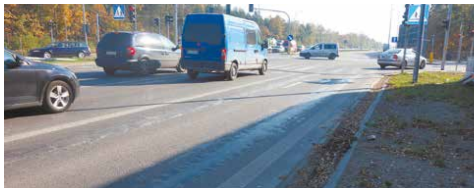
Na jezdni widać czarne garby z masy asfaltowej
