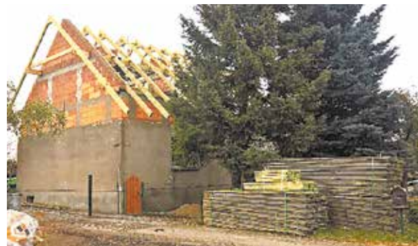
Zebrań środki poszły na wykonanie nowej więźby dachowej
