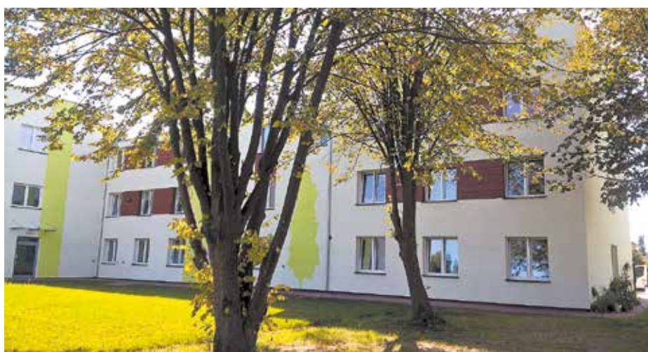
Budynek po remoncie
