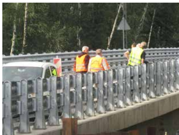
Prace już zakończono, ale wciąż nie ma zgody na oddanie obiektu
