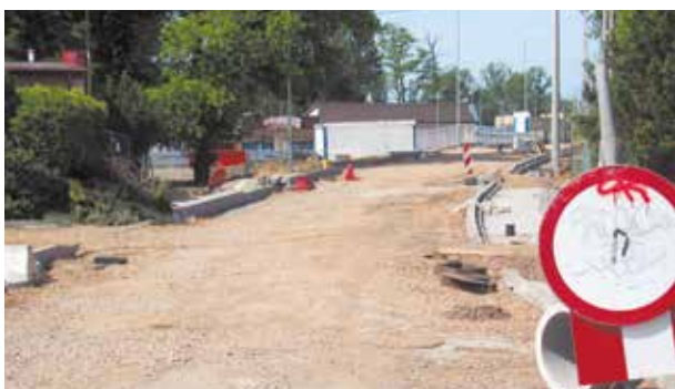
Wiadukt dopiero w budowie
