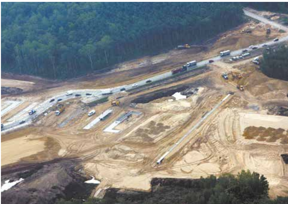
Budowa drogi S8 węzeł „Zielonka”
