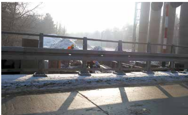
Wreszcie na terenie budowy widać jakieś prace
