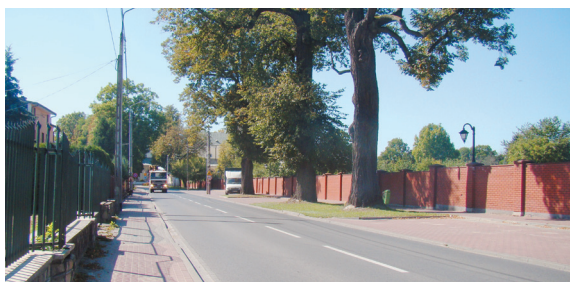
Rozbudowa drogi powiatowej nr 4352W w Kobyłce
