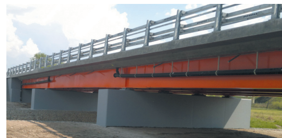
Przebudowa mostu w Starym Dybowie
