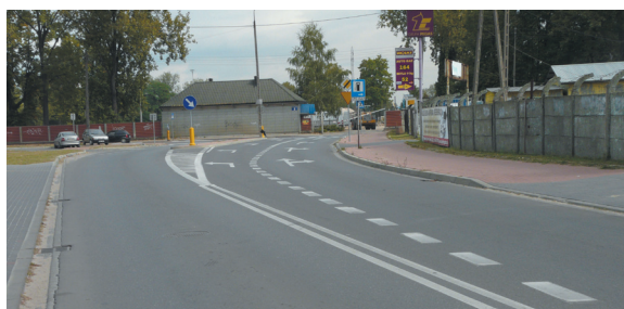
Rozbudowa ul. Armii Krajowej w Wołominie
