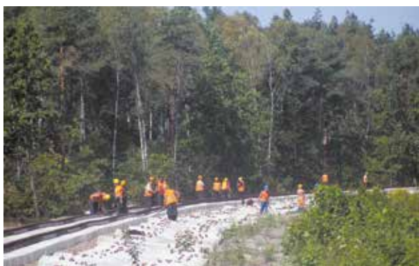
Prace na torach między Rembertowem a Zielonką
