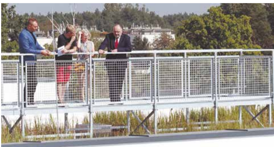
Oba budynki posiadają dach bagienny z roślinnością
