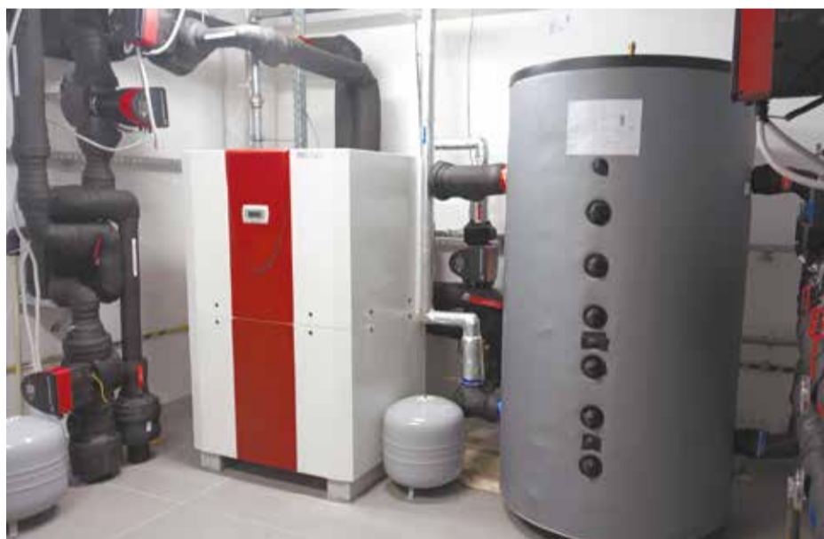
Pompa ciepła z dolnym zasilaniem - serce całej instalacji
