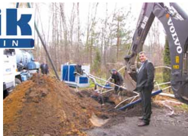
Prezes PWiK Wołomin Paweł Solis na placu budowy
